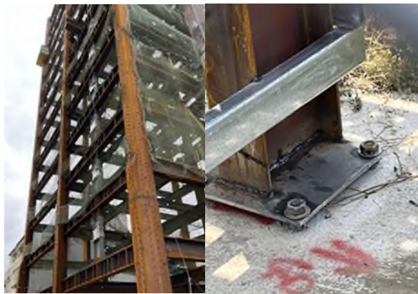
解說圖 98-1：建築物之金屬構架作為接地電極
